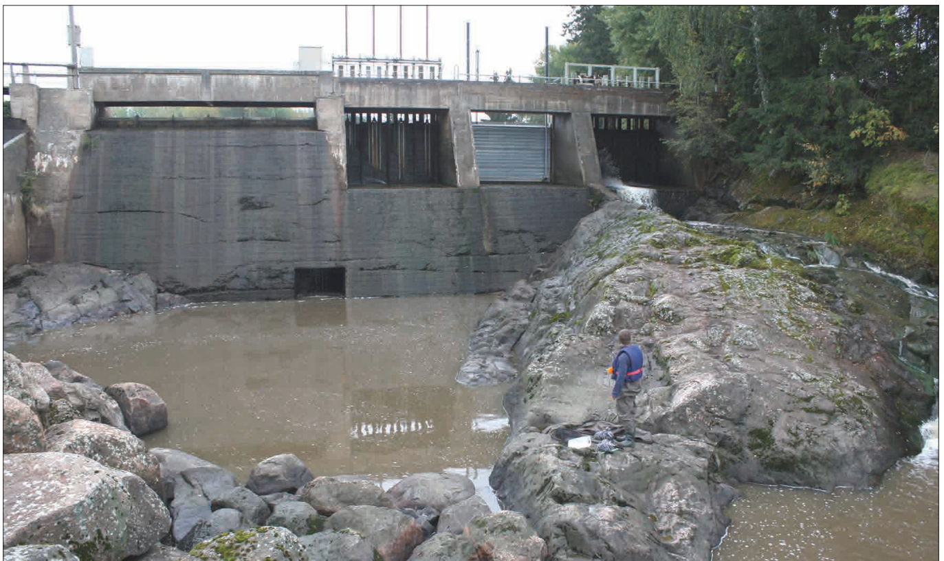
Kuva 11. Strömsbergin voimalaitospato valmistui Porvoonjokeen vuonna 1919. Pato esti täydellisesti vaelluskalojen pääsyn Porvoonjoen koskialueille. Vuonna 2000 valmistui kalatie, joka mahdollistaa jälleen vaelluskalojen paluun jokeen. Vaelluskaloilla on kuitenkin ilmeisiä vaikeuksia löytää kalatien suuta ja kaloja hakeutuu virtausten houkuttelemisena ainakin aluksi padon alapuolelle. Osa voi löytää kalatien myöhemmin, mutta ei ole tarkoitus, että vaelluskalat joutuvat etsiskelemään nousureittiä. Padottu koski on muutenkin luonnon ja vaikea paikka vaelluskaloille, joten kalatien löytyminen helposti on tärkeää.
