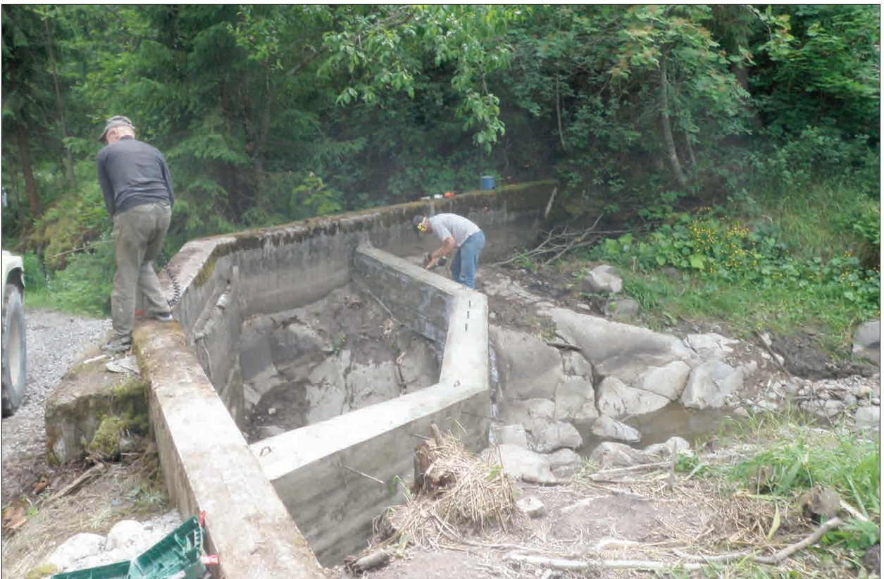
Kuva 8. Kun työpato puretaan, säilyttää padon uusi lisäsiipi yläpuolisen vedenkorkeuden. Joen vesi virtaa jälleen luonnonkoskeen mahdollistaen elämän koskessa. Tulvavesi pääsee lisäsiiven yli entiseen turbiiniputkeen ja rajoittaa siten veden tulvimista koko patorakenteen yli.
