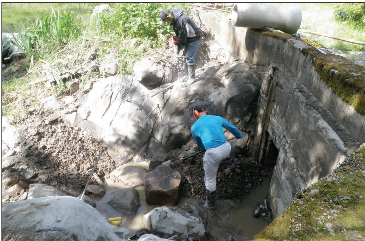
Kuva 6. Padon rakenteet raudoitettiin kallioon ja padon alle valettiin antura. Yleensä jokitalkkarit Sampo Vainio ja Juha Niemi (kuvassa) mieluummin purkaisivat patoja kuin rakentaisivat niitä, mutta tällä kertaa ratkaisulla saavutettiin monipuolisia hyötyjä.
