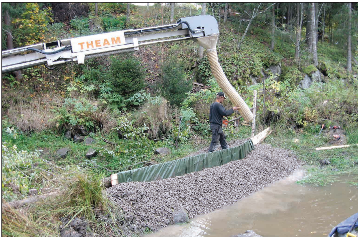
Kuva 5. Myllylän vanhan turbiiniaukon tukkeiden petettyä yläpuolinen patoallas kuivui. Muutosurakka patoaltaan vedenpinnan palauttamiseksi ja vanhan luonnonkosken vesittämiseksi alkoi työpadon rakentamisella.
