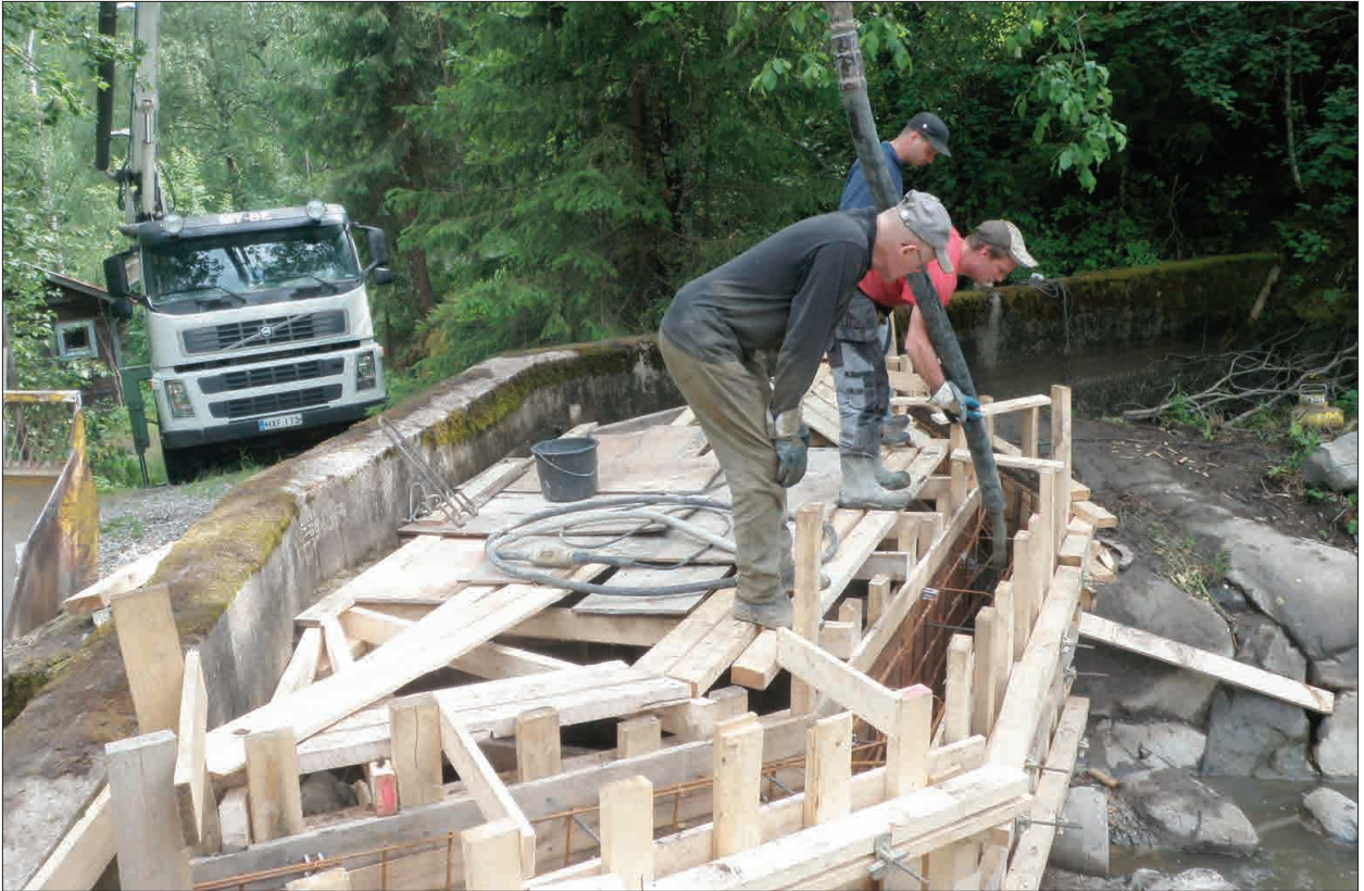
Kuva 7. Jokitalkkareiden rakentaman muotin valmistuttua päästiin valamaan pato. Työvaltaisen vaiheen jälkeen alkoi lopputulos hahmottua. Edessä työmaan mestarina toiminut Seppo Myllylä.
