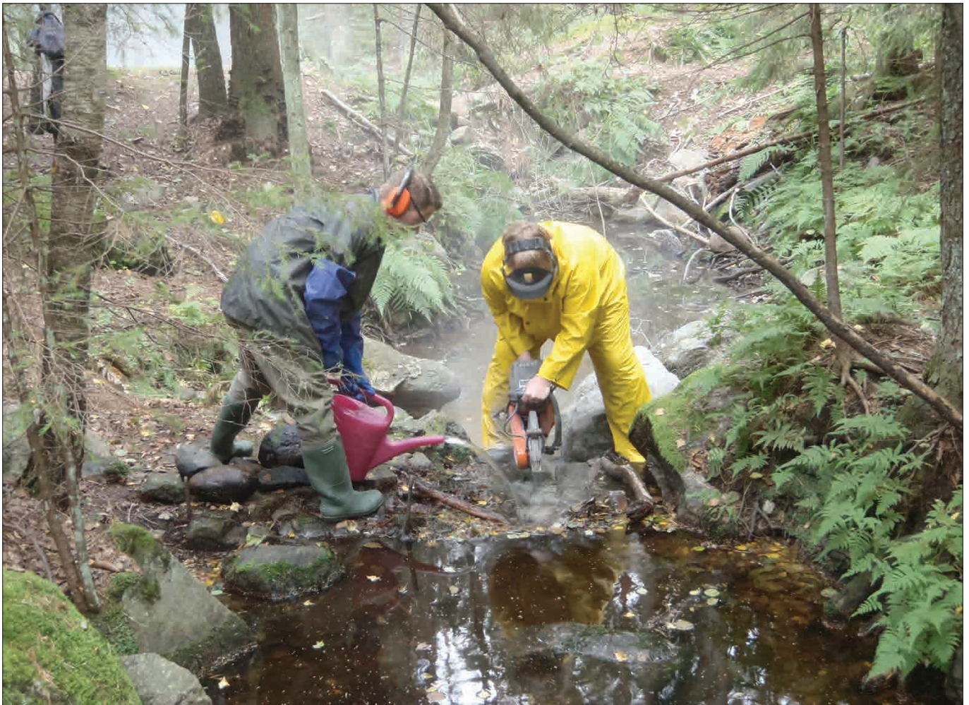
Kuva 9. Pilvijärvenpuron vanhaan patoon leikattiin kapea V-mallinen aukko, josta järven vesi laskee puroon hitaammin ja kauemman aikaa. Murtuneen padon rakenteita kivettiin ja pato on luonteeltaan kuin pieni luonnonkoski.
