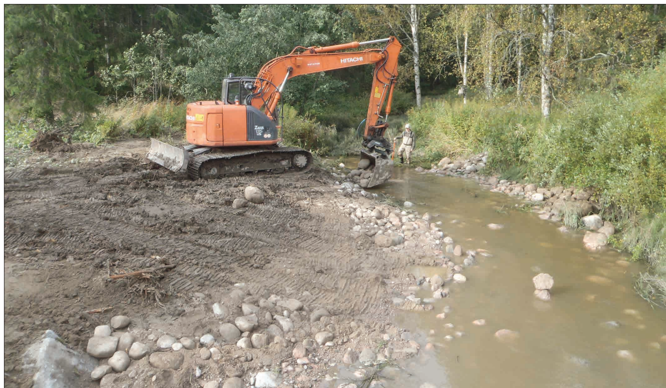
Kuva 2. Orimattilan Palojokeen rakennettiin kivikkoinen virtapaikka, jolloin lohikaloille saatiin soraikoita kutua varten ja hyvä alue poikasten kasvulle. Tarkoituksena on saada Palojokeenkin luontaisesti lisääntyvä taimenkanta.
