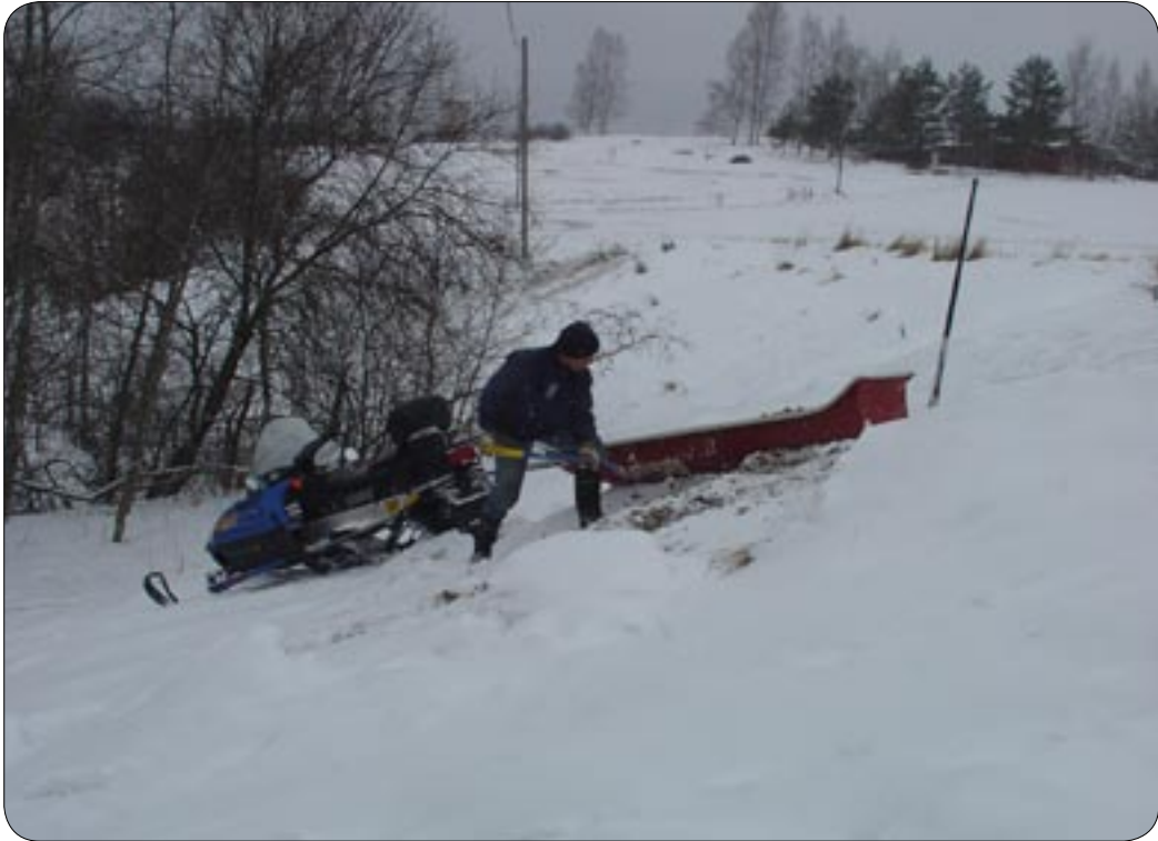
Kuva 7. Osa sorasta kuljetettiin vielä moottorikelkan ja ahkion kanssa lopullisten sijoituspaikkojen viereen puron reunaan. Jälle soraa ei kuitenkaan levitetty, vaan se säilöttiin pressujen päälle rannalle.
