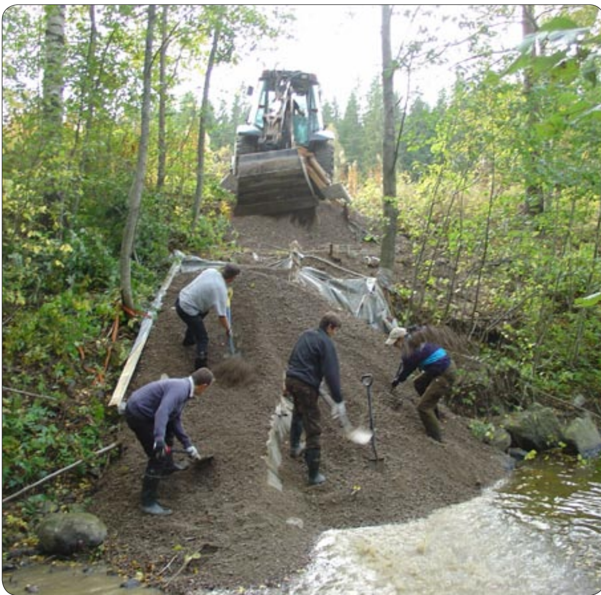
Kuva 18. Orimattilan ja Kärkölän rajalla sijaitsevaa Koskelankoskea kunnostettiin kiveämällä vuonna 2006. Nyt kosken soraistettiin talkoovoimin kutusoraikkoa. Aluella on todettu puronierian ja harjuksen lisääntyvän luontaisesti. Taimenistusten takia myös taimenen luontaisen lisääntymisen odotetaan käynnistyvän lähitulevaisuudessa.
