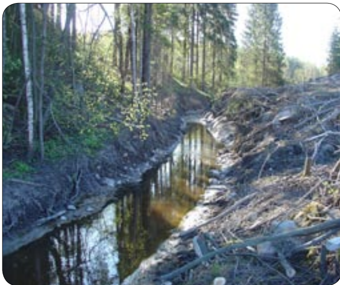
Kuva 11. Byabäckenin perkaus oli varmasti tarpeen viljelyn kannalta, sillä tulvavesi nousi kapeasta ojasta alaville pelloille. Byabäckenin kaltaisessa vesistössä perkaus olisi kuitenkin ehdottomasti pitänyt toteuttaa vesistön luonne huomioiden ja alaosan koski (kuvassa kosken niska) olisi pitänyt säilyttää luonnonluisempina. Kosken kunnostus on edelleenkin mahdollista.
