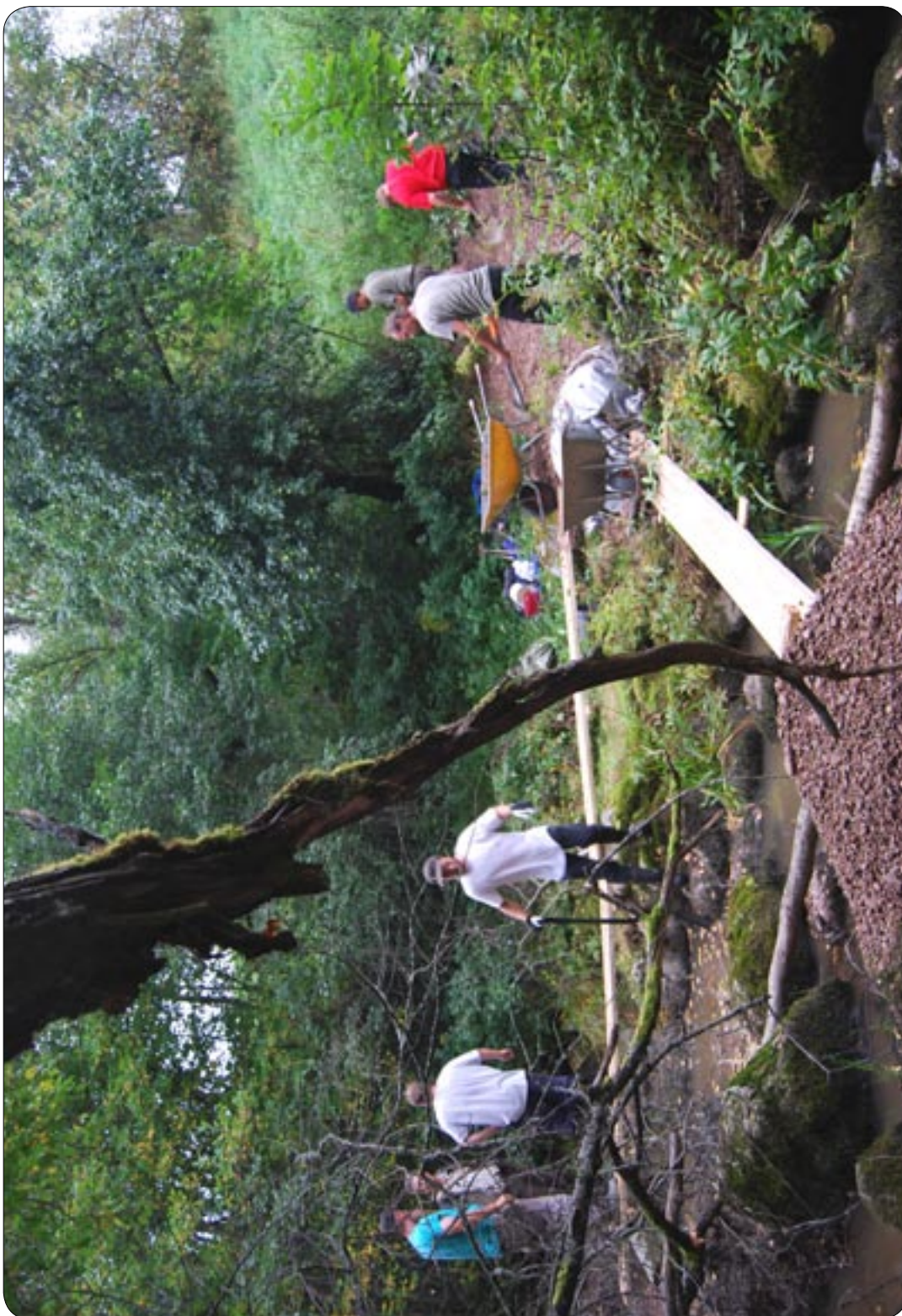
Kuva 9. Soraa kärrättiin lankkusiltoja pitkin uoman keskelle ja levitettiin koko uoman leveydeltä paikkoihin, jossa soran päälle jää kohtalainen veden virtaus. Noin 35 tonnin soraäärällä kunnostettiin viisi sorakkoa.
