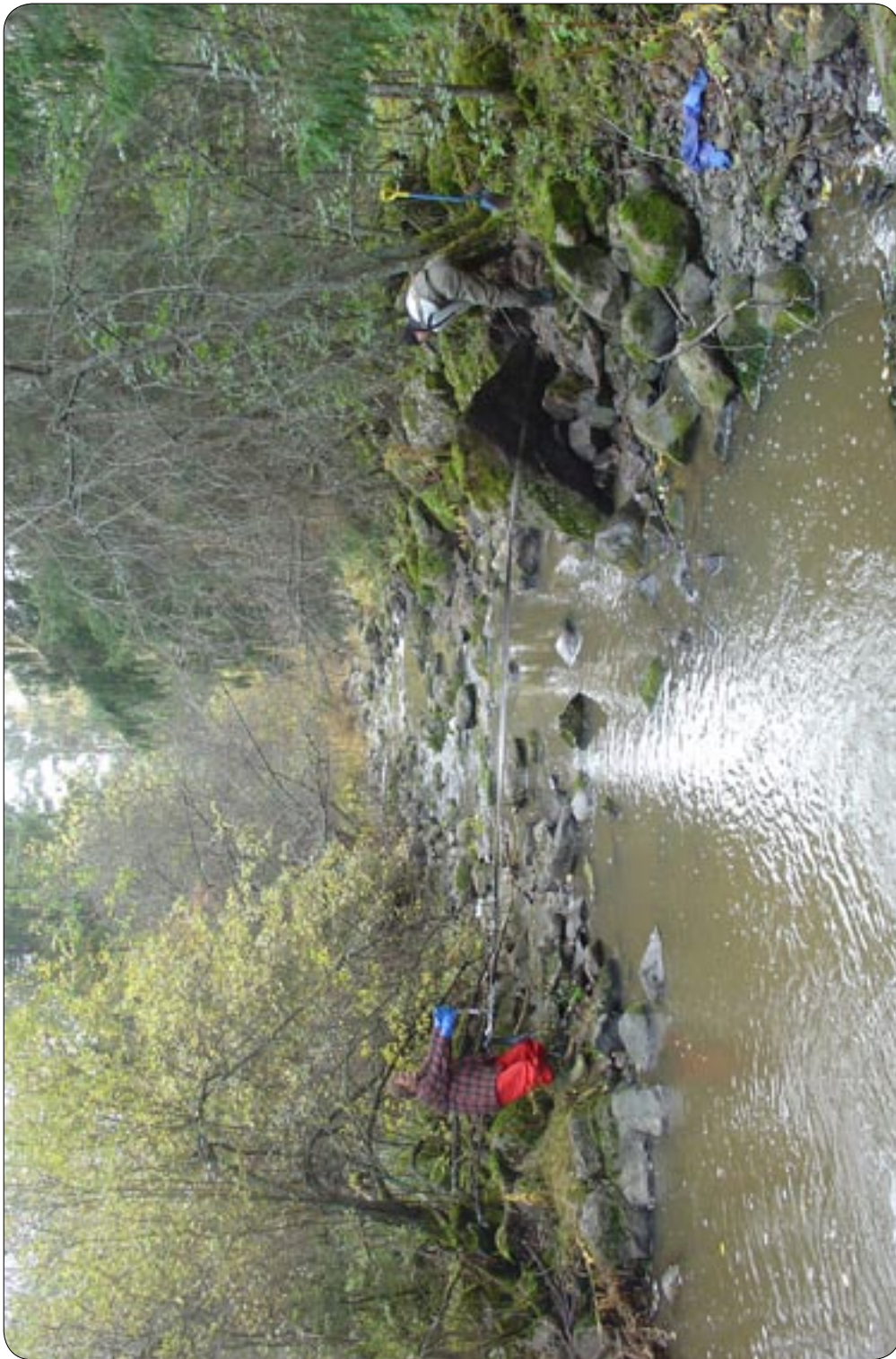
Kuva 17. Korttianskosken kiveykset toteutettiin käsityönä. Kun lapio ja rautakanki eivät riittäneet, saatiin suurimmat kivet liikkumaan vinssin avulla. Kivassa kallion alapuolella olevan sivannon vedenpintaan vaikutettiin siten, että virtaaman kasvaessa kivet aluksi nostavat vedenpintaa ja kalojen nousu kallioluiskan yli helpottuu. Tulvavedet mahtuvat virtaamaan uomasta entiseen malliin. Työn touhussa ovat yhdistyksen työntekijät Tero Myllyvirta ja Juha Niemi.
