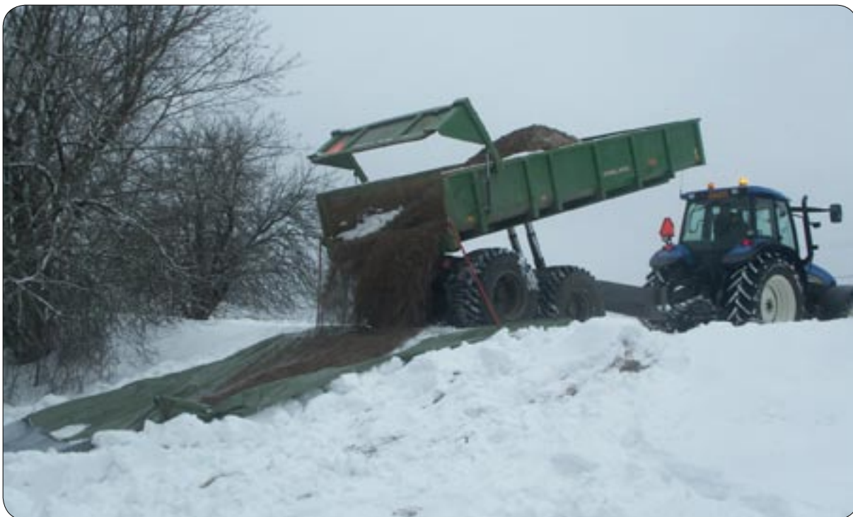
Kuva 6. Sora lastattiin ensin traktorin peräkärriin ja kuljetettiin puron penkalle jäätyneen pellon yli. Osa sorasta saatiin valutettua rinnettä alas purolle pressuja pitkin.
