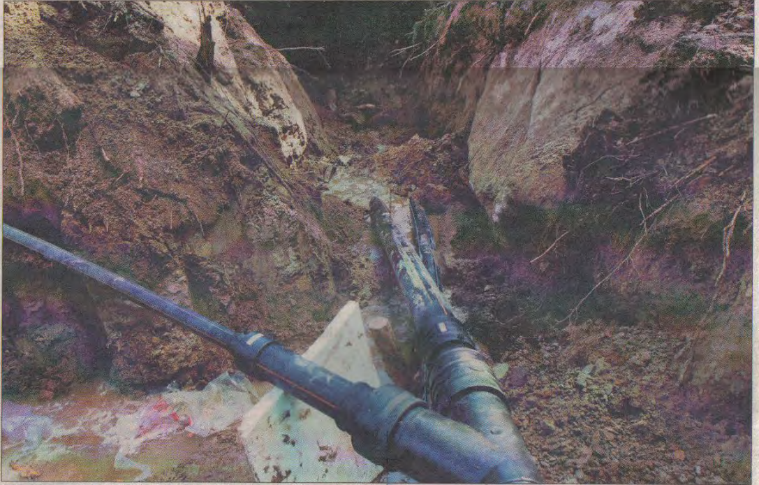
Föreningen vatten och luftvård i Östra Nyland och Borgå å håller på att avsluta ett längre projekt kring hur invånare på glesbygden kan handskas med avloppsvattnet på ett vettigt sätt efter att den nya förordningen träder i kraft 2016. FOTO: LAURI ASANTI/KSF-ARKIV
