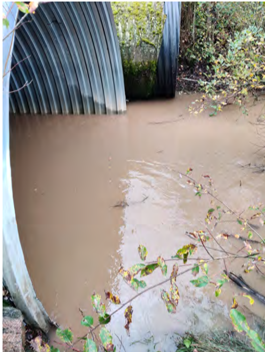
Kuvat 2 ja 3. Saarentien siltarummut ovat vetoisuudeltaan melko suuret, mutta tulvarummu on sijoitettu nykyisellään niin ylhäälle, että vesi ei kulje tulvarummun kautta kuin erityisen voimakkaiden ylivirtaamakausien aikana. (Kuvat: Juha Niemi, 27.9.2024).
