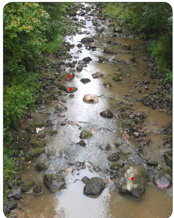
Kuva 84. Kunnostuksessa kosken pohjaa monimuotoistettiin kaivamalla syvänteitä ja kiveämällä suojapaikkoja. Kuivien aikojen vesipinta-alaa saatiin myös laajennettua. (Kuva: Sören Broman)
