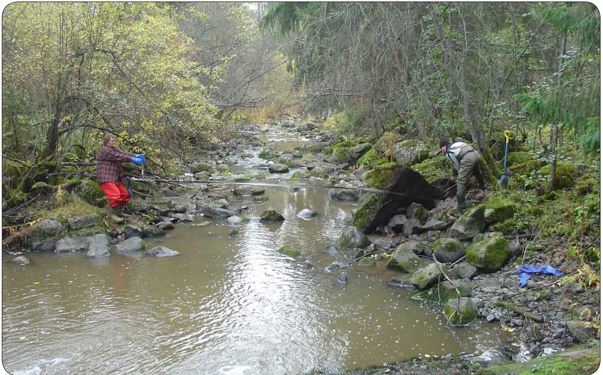
Kuva 67. Korttianskosken kallioluiskan alle vinssattiin suuria kiviä jarruttamaan virtausta keskiveden aikana. Kallioluiskassa on pudotuskorkeutta liki kaksi metriä. Kivet nostavat kalojen nousulle sopivissa olosuhteissa veden pintaa kallioluiskan alapuolella ja kalojen pääsy kallioluiskaa pitkin ylöspäin helpottuu.
