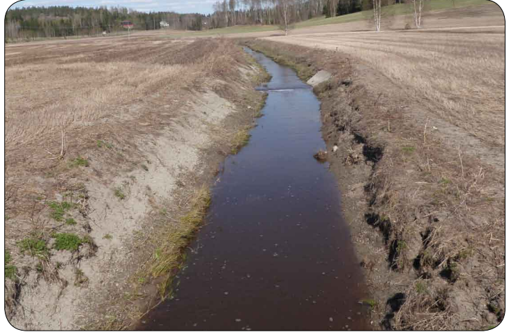
Kuva 43. Byabäckenin latvaa vuosi perkaamisen jälkeen. Ojan reunoille ei ole ehtinyt tulla sitovaa kasvillisuutta. Ojan reunat syöpyvät ja sortuilevat ja kiintoaines kulkeutuu alavirtaan taimenen elinalueille.
