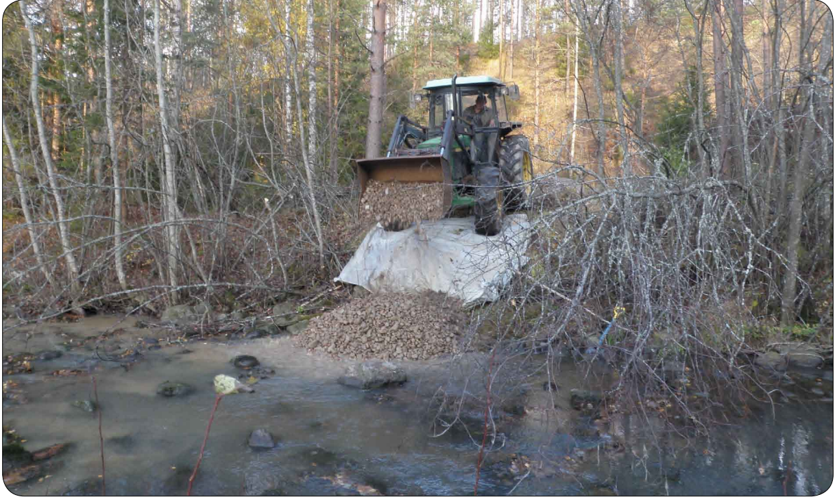
Kuva 93. Myrskylänjokeen laskevan Karsojan koskeen kunnostettiin kolme erillistä kutusoraikkoa. Viereisen metsäautotien ja joen väliin raivattiin pusikkoon aukot, josta sora saatiin tuotua jokeen asti traktorilla.
