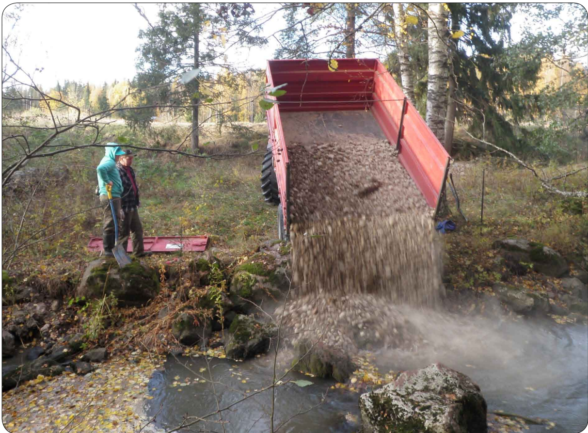
Kuva 86. Kutusora tuotiin Hakannurkankoskelle traktorilla pienissä erissä, sillä ajoreitti koskelle ei ollut aivan helppo. Sora saatiin joen penkalle asti, mistä sora levitettiin lapiolla koko joen leveydelle.
