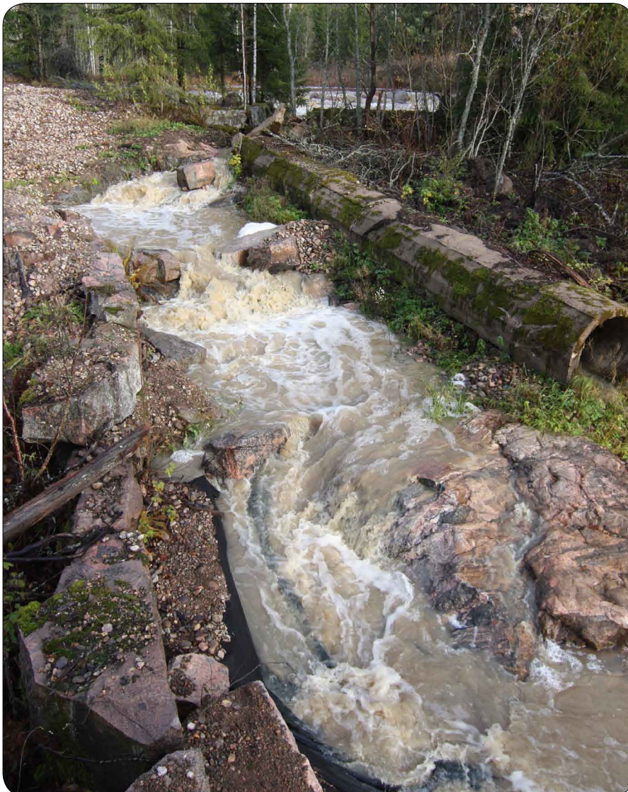
Kuva 103. Köylinkosken jyrkän kallioluiskan sivuun rakennettiin ohitusuoma. Ohitusuoma rakennettiin vanhan sahan kivijalan ja vesiputken väliin. Ohitusuoma on kokonaan kalliopohjainen.
