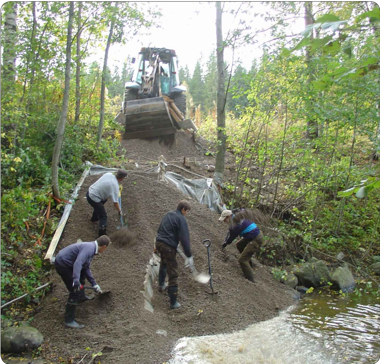
Kuva 72. Orimattilan ja Kärkölän rajalla sijaitsevan Koskelankosken kunnostus aloitettiin kiveämisellä vuonna 2006. Vuonna 2009 kunnostettiin kosken niskalle soraikkoa paikallisin talkoovoimin.
