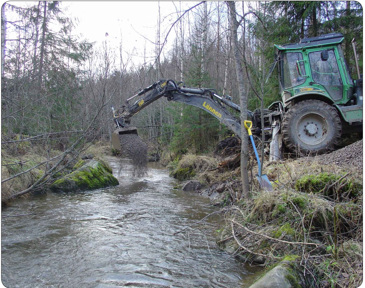
Kuva 71. Hahmajoen alajuoksun virtapaikassa soraistus voitiin tehdä konetyönä. Suojapaikkojen kiveämisen uoman pohjalle oli käsityötä.
