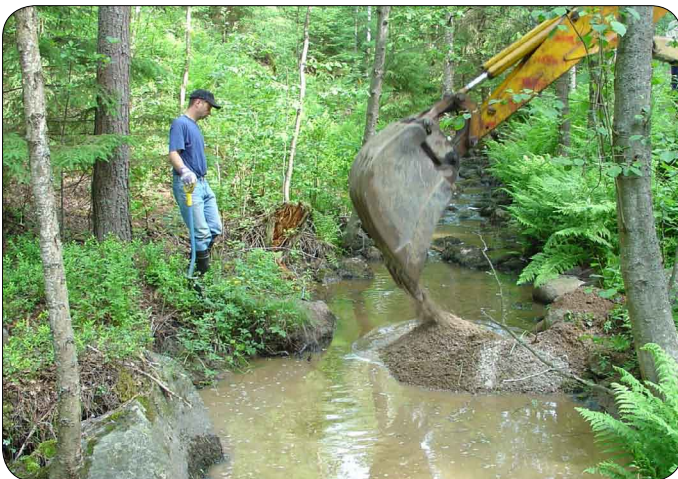
Kuva 91. Pääosa sorasta voitiin nostaa kaivinkoneen kauhalla tieltä suoraan puroon asti. (Kuva: Juha Niemi).
