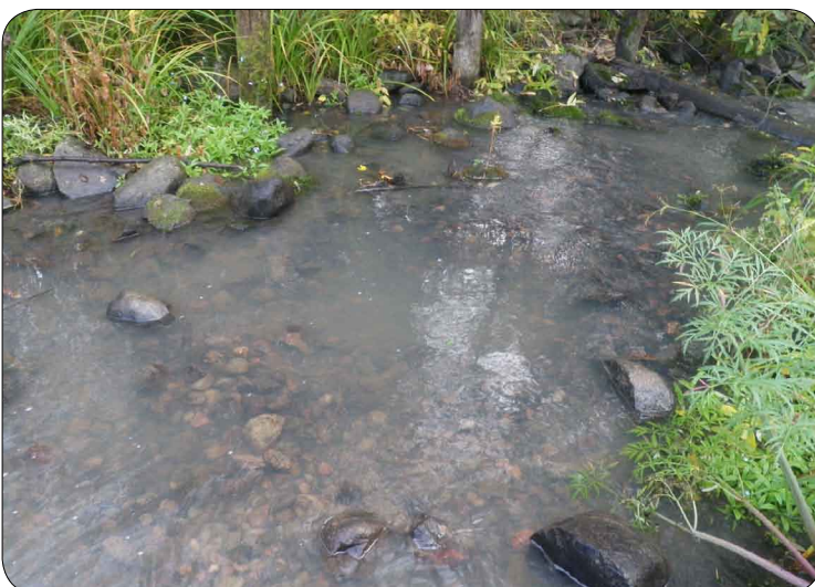
Kuva 76. Kiinni kittautunutta pohjakivikkoota ja soraikkoota irroitettiin rautakangen ja lapion kanssa Torpinjoella Pukkilassa.
