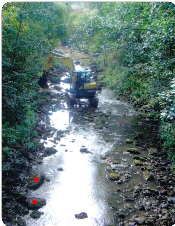
Kuva 83. Kaivinkone ajettiin peratun kosken pohjalle kosken niskalta. Kaivinkone peruutti takaisin kohti kosken niskaa kunnostaen samalla. (Kuva: Ray Broman)
