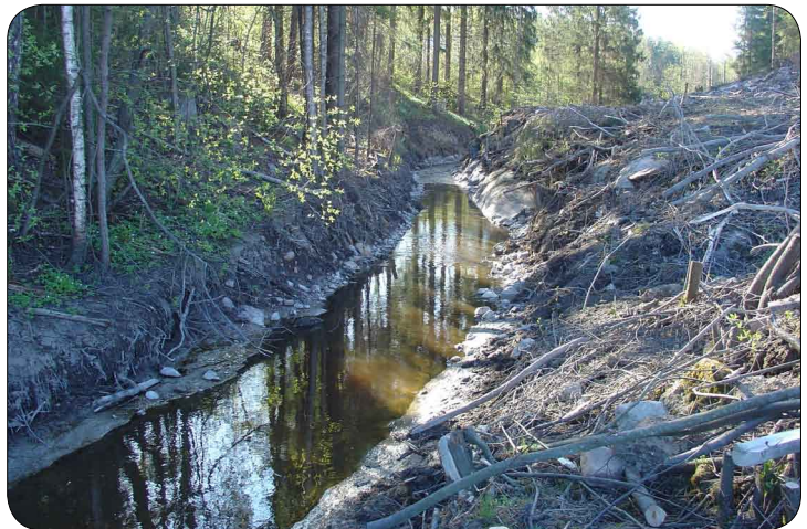
Kuva 44. Byabäckenin ylin koski Ängesbölebergetin kupeessa perattiin myös. Tällaisia rännejä ei saisi kaivaa enää mihinkään vesistöön, vähiten arvokkaaseen taimenpuroon.
