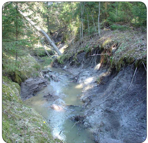
Kuva 52. Kungsbäckenin sameus aiheutuu suurelta osin latvojen metsäojista, jotka syöpyvät yhä syvemmälle savimaahan. Syöpymisen voisi pysäyttää esimerkiksi pohjakynnyksen avulla.
