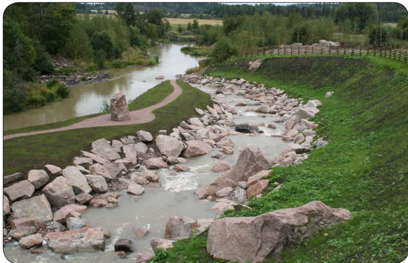
Kuva 107. Syksyllä 2008 valmistunut Kuuskosken kalatie avasi vaelluskaloille mahdollisuuden nousta koko Koskenkylänjoen alueelle. (Kuva: Pasi Lempinen, Uudenmaan ELY-keskus).
