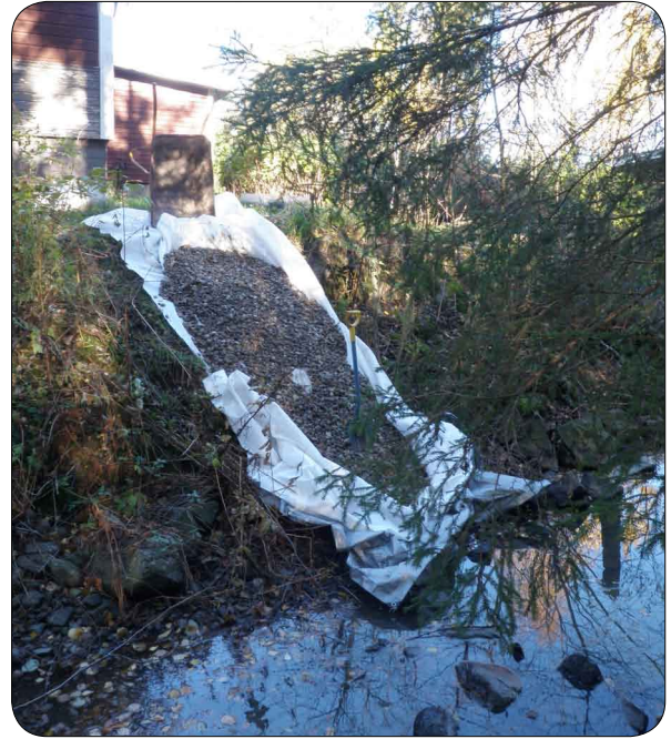
Kuva 55. Isonnittynojan vesistössä tehtiin myös soraikoiden huoltoa pöyhimällä kutusoraikoita ja lisäämällä soraa.
