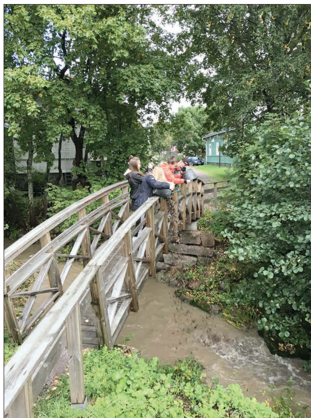
Kuva 30. Loviisankosken viimeistelytyöt ja kunnostusalueen siivoaminen tehtiin jokitalkkareiden ja Lovisa Gymnasiumin oppilaiden toimesta.
