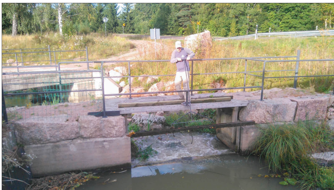
Kuva 29. Kuuskosken kalatie pidetään auki kalojen vilkkaimpina nousuaikoina keväällä ja syksyllä. Muulloin kalatien sulkevat lankut ohjaavat pääosan vedestä Kuuskosken voimalaitokseen.
