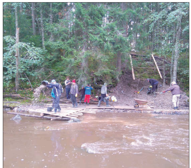
Kuvat 15-18. Lukkokosken kunnostusta rakennettiin vaneriluiska kosken jyrkkään reunaan, jotta sora saatiin kosken rantaan asti. Kunnostuksen viimeistelytyöihin osallistui Pornaisten nuoret kalastajat ry:n talkooryhmä.
