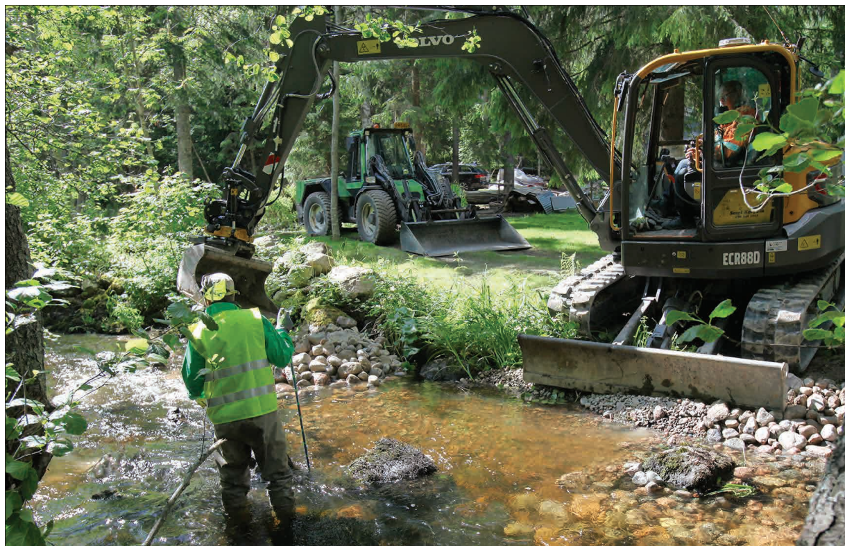
Kuva 26. Seestaanjoen ensimmäiseksi kunnostuskohteeksi valittiin Isomäen kohdalla oleva koskialue. Kunnostustyö toteutettiin telakaivinkoneella ja pyöräkuormaajalla.
