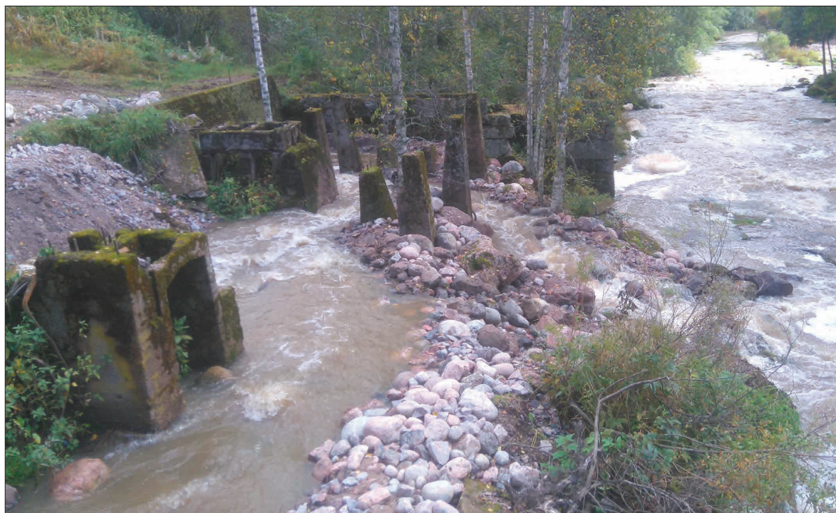
Kuva 19. Orimattilan Myllykulmankoskeen kunnostettiin vanhan raamisahan uomaan poikasaluetta, joka toimii myös patorauunion kohdalla ohitusuomana.
